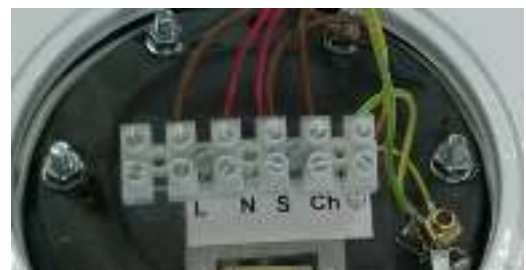
Рис. 3 Фото. Колодка подключения встроенного термостата бойлера STOUT.
